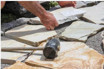
Der „Problemverursacher“ Nr. 1 im Außenbereich ist Wasser. Feuchtigkeit unterhalb des Steinbodens verursacht Wasserflecken und kann auf Dauer sowohl den Unterbau und/oder die Natursteinplatten und Fugen schädigen (z.B. in Verbindung mit Frost!). Staunässe durch nicht abfließendes Regenwasser oder durch übermäßiges Gießen sorgt für Kalkflecken und ist außerdem der ideale Nährboden für Grünbelag und Algen.
